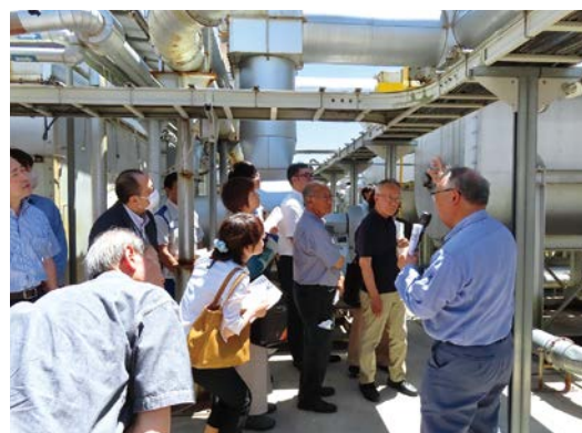
久慈バイオマスエネルギーのプラント内を見学
